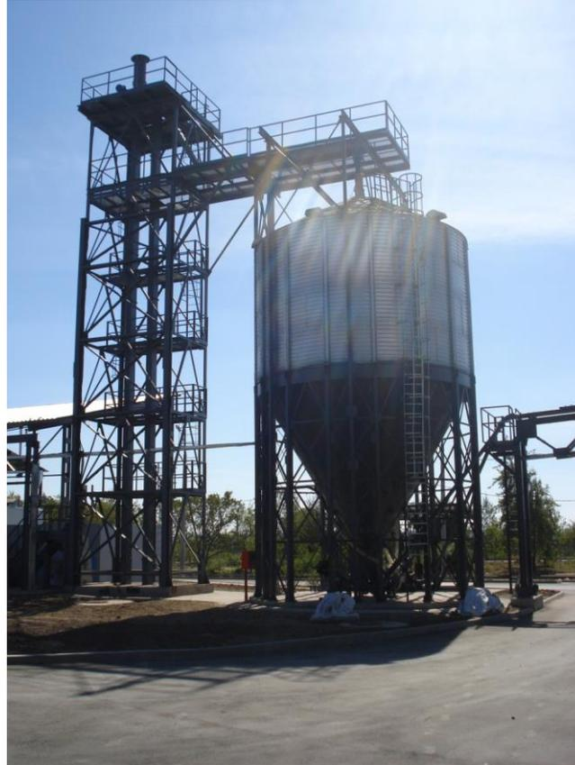
Включает навес, бункер приема топлива, транспортеры подачи топлива, кран-балку и разгрузчик биг-бэгов. Ориентировочная стоимость – 1 млн.грн.
